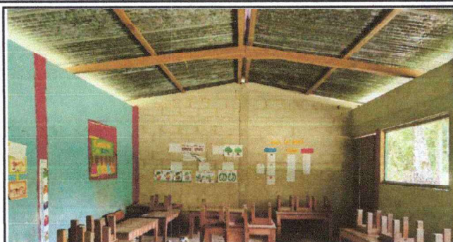
Foto1: Desmontaje de madera por estructura de metal y cubierta de lamina. Asi mismo se aplicara pintura en el interior del establecimiento.
